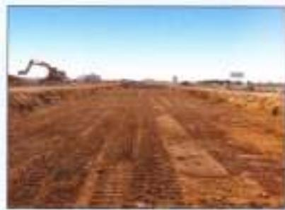
Depósito de infiltración GRAF de 1.195 m<sup>3</sup> construido
