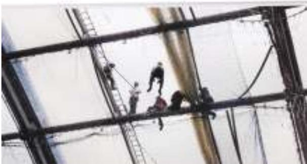
Las Redes de Posicionamiento en el trabajo proporcionan un entorno de trabajo seguro, que da confianza al montador de la estructura o cubierta gracias a 2 ventajas básicas:
