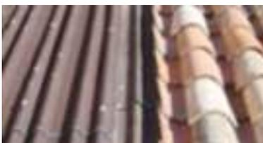
Máxima ventilación. Dota a la cubierta de una ventilación regular, tanto entre el soporte y las placas como entre las placas y las tejas, evitando condensaciones y alargando la vida de la cubierta.
