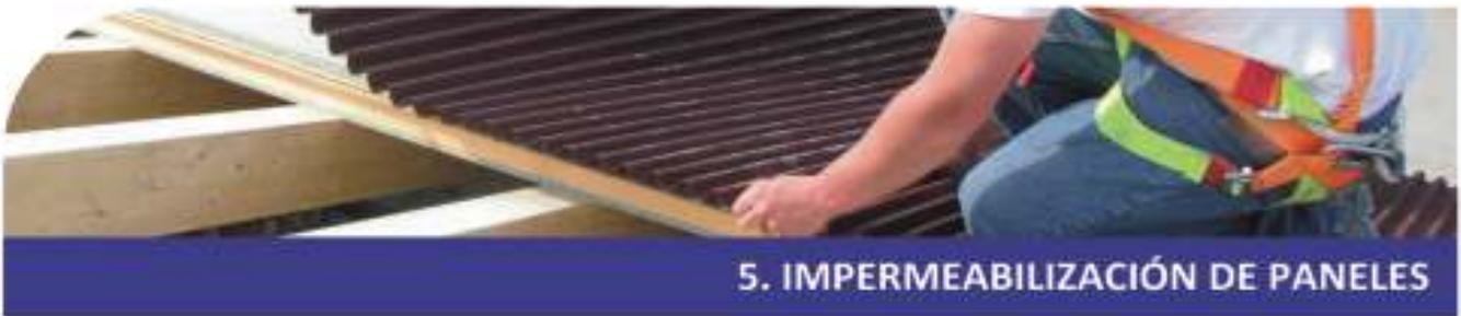
Una vez realizada una cubierta con paneles sándwich Ondutherm, es necesario impermeabilizarla y ventilarla con el sistema Onduline Bajo Teja.
